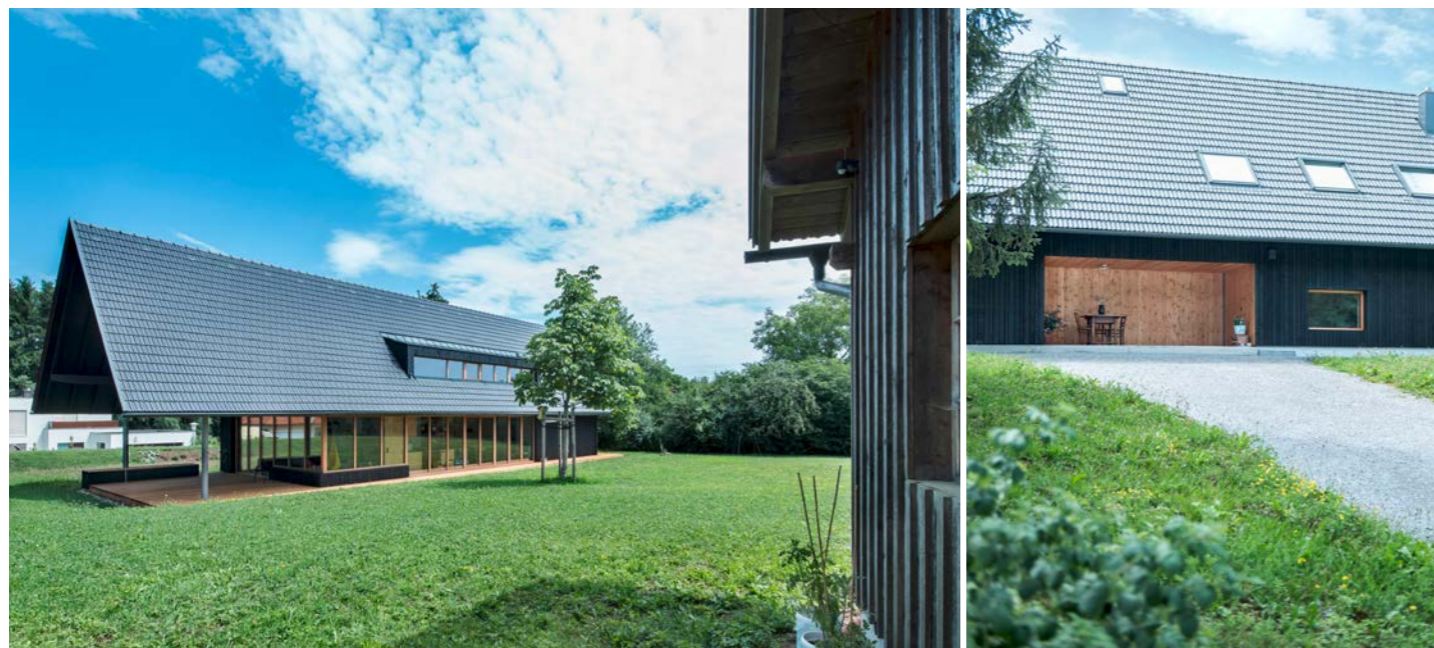
Gute Architektur in St. Peter an der Au: Ein langes Haus fürs Wohnen unterm Dach und in der Sonne. Die Fassade ist mit Fichtenlatten verkleidet.
