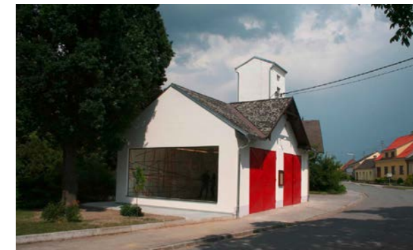
Bröckelndes Mauerwerk, altes Eisen – eigenwillige Kunstwerke bieten sich bei manch einer „Landpartie“ (oben). Ein ehemaliges Feuerwehrhaus liegt ebenso am Weg – heute ein Ausstellungsraum (unten).
